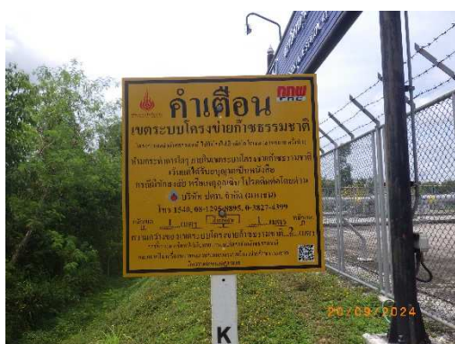
รูปที่ 2-5 ป้ายเตือน (Pipeline Markers)
