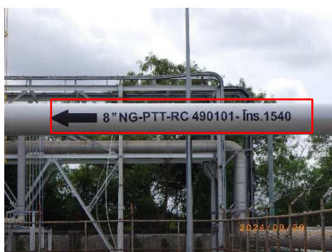
รูปที่ 2-6 สัญลักษณ์แสดงตำแหน่งแนวท่อ โดยมีข้อความและหมายเลขโทรศัพท์แจ้งเหตุอย่างชัดเจน
