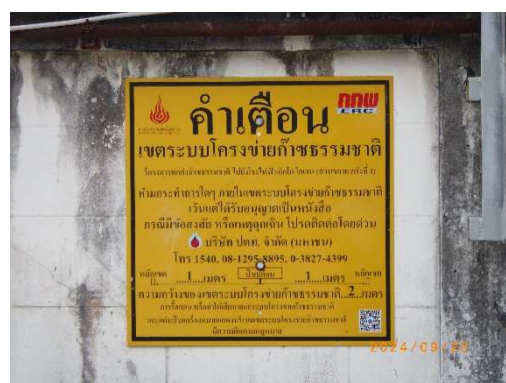
รูปที่ 2-5 ป้ายเตือน (Pipeline Markers)
