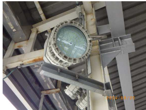
รูปที่ 2-12 อุปกรณ์ป้องกันการระเบิด (Explosion proof) บริเวณสถานีควบคุม
