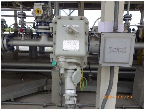
รูปที่ 2-12 อุปกรณ์ป้องกันการระเบิด (Explosion proof) บริเวณสถานีควบคุม
